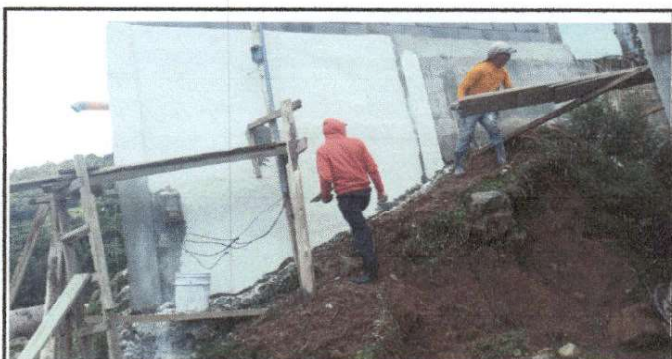
Foto 5: Reparando el muro perimetral de block.
