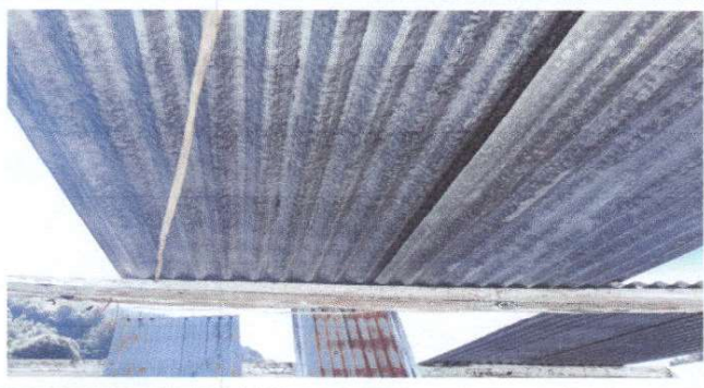
Foto 1: Sustitución de lamina por lamina troquelada calibre 28.
