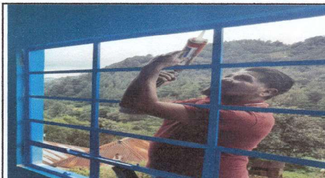
Foto 4: Sustitución de ventanas de madera por metal e instalando vidrios.
